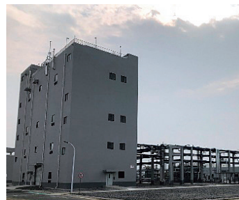
製造受託設備
