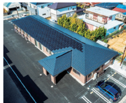
屋根に設置した太陽光パネルから光を効率よく集約
