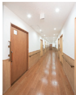
抗ウイルス手すりや衝撃吸収材を使用した施設内
