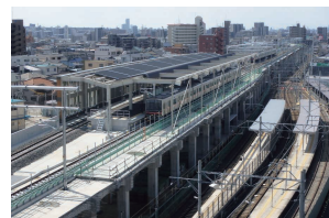
喜多山駅付近高架化
