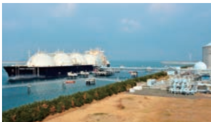
カーボンニュートラルLNG積載船のひびきLNG基地への初入港
