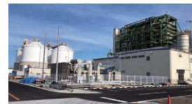
米子バイオマス発電所
