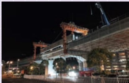
佐世保高架橋（拡幅）工事 （長崎県佐世保市）
