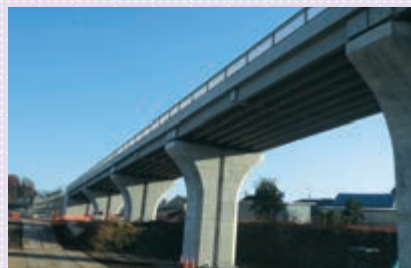
竹下第3高架橋工事 （栃木県宇都宮市）
