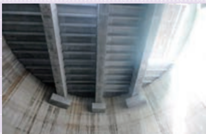
守口立坑頂版工事 （大阪府守口市）
