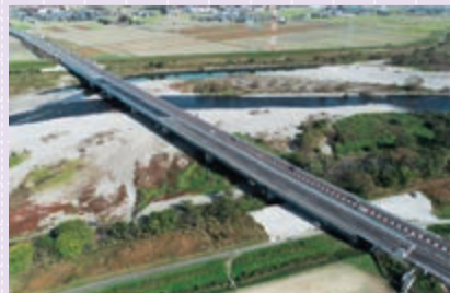
九頭竜川橋（他2橋）床版取替工事 （福井県福井市）
