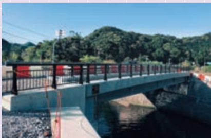
国道42号堂道橋上部他工事 （和歌山県東牟婁郡申本町）
