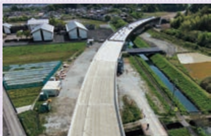
高知西BP波川高架橋上部P2-P4工事 （高知県吾川郡いの町）
