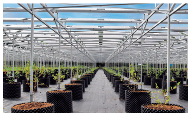
所沢北岩岡太陽光発電所 (ソーラーシェアリング)
