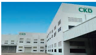
所在地：タイ王国 チョンブリ県 AMATA工業団地内 敷地面積：約22,000㎡ 建屋面積：約15,000㎡ 不動産取得額：約11億円
