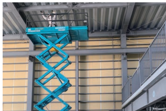
高所作業車 配線・配管作業現場
