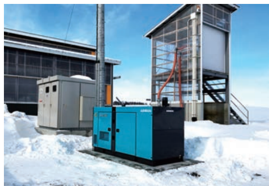
非常用発電機 設置現場
