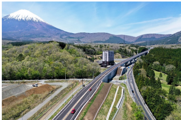
138号BP須走南地区舗装工事 (国土交通省中部地方整備局)
