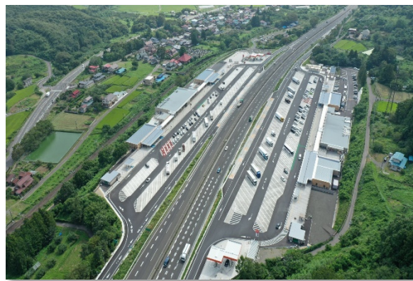
東北自動車道 本宮～白石間舗装補修工事 (東日本高速道路株式会社)
