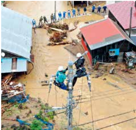
台風9号に伴う停電の復旧作業
