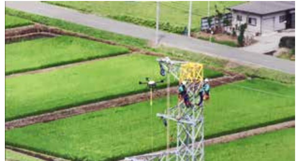
ドローンを活用した送電線の延線作業
