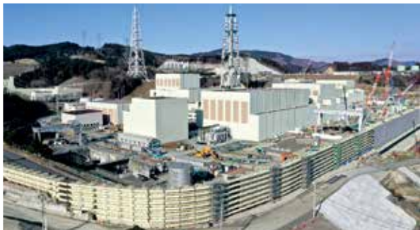
安全対策工事が進む女川原子力発電所
