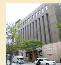
ニッケ神戸本店ビル （兵庫県神戸市）
