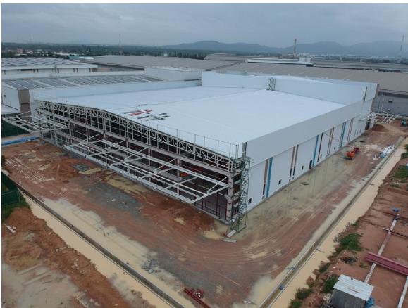
<建設中の第3工場>
