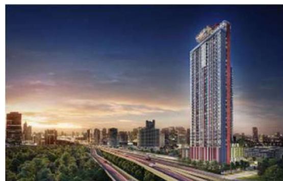
Rama 9 PJ フェーズ2 (タイ) 全体戸数：2,248戸 当社シェア：49% 竣工：2021年6月
