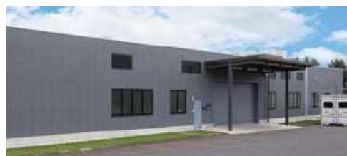
バッテリー安全認証センター
