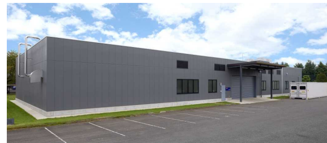
バッテリー安全認証センター
