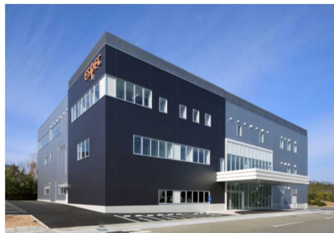
技術開発棟の外観
