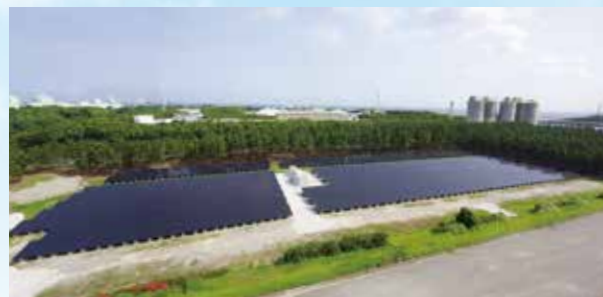
中袖基地内遊休地を利用した太陽光発電事業 (2014年6月竣工・送電開始)
