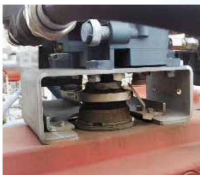
バルブ診断システムを導入しているバルブ (弁開度の偏差で不具合を事前に検知可能)
