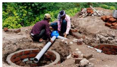
Installing V-Trap toilet
