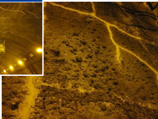
吹付けモルタルトンネル
