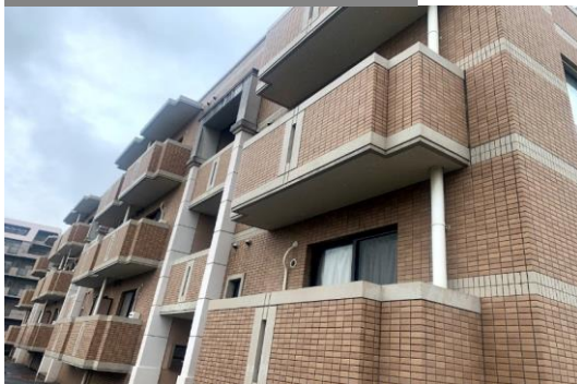
施工前 アパート
