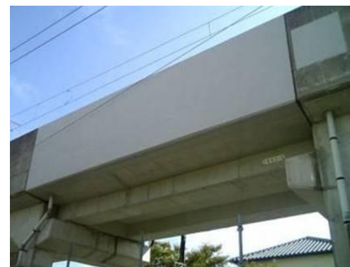
はく落防災コーティング
