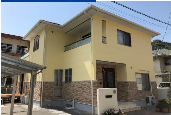
施工後 戸建て住宅
