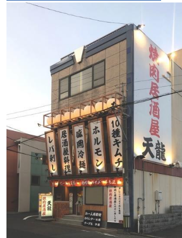
店舗新装工事
