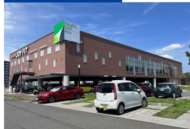
施工後 複合施設
