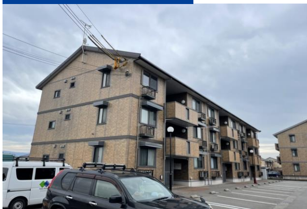
施工後 集合住宅
