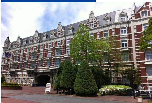
施工後 テーマパーク
