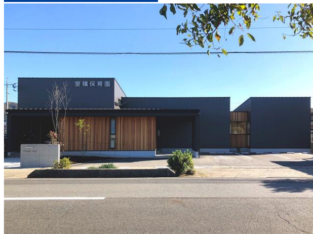
保育園新築工事
