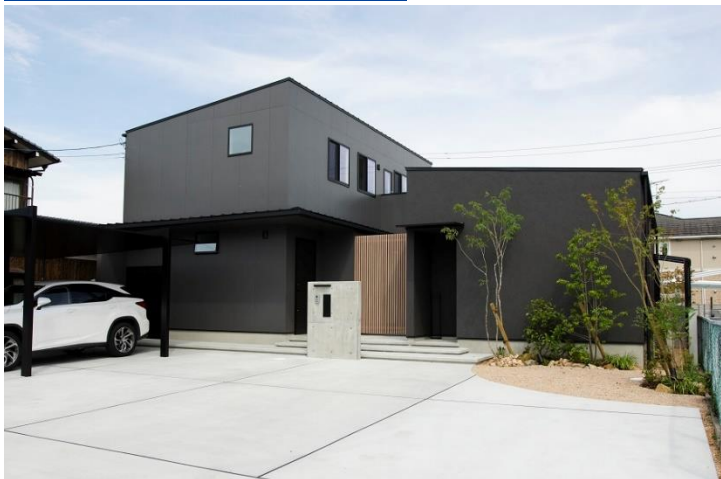
新築工事（戸建て住宅）
