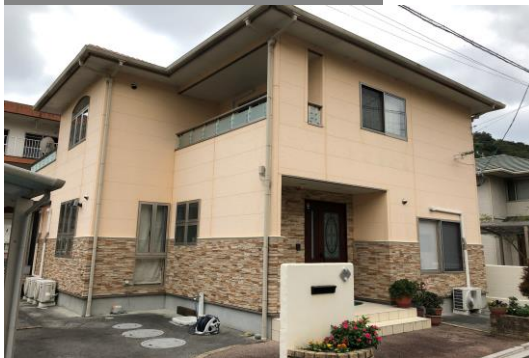
施工前 戸建て住宅
