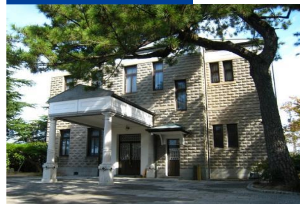
施工後 国有文化財
