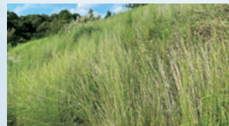
施工後5か月経過
