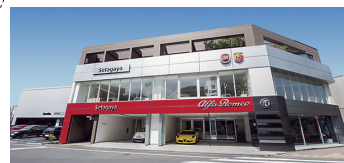
フィアット/アルファト世田谷
