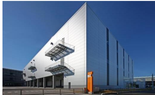
2 ロジスクエア八潮 2014年1月竣工
