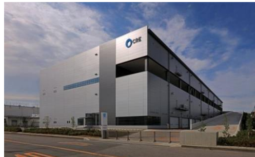
4 ロジスクエア久喜 2016年6月竣工
