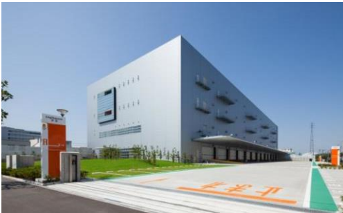
1 ロジスクエア草加 2013年6月竣工
