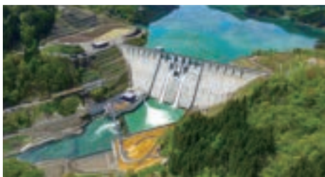
津軽ダム (青森県) 2016年 当社が施工した直上流60mに位置する目屋ダムの再開発に位置づけられた多目的ダムで、打設工期の短縮が可能な「巡航RCD工法」を採用 土木学会デザイン賞2018最優秀賞、2017年度土木学会技術賞
