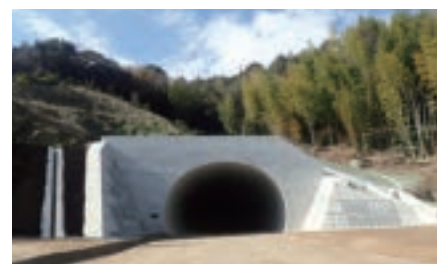
六条院トンネル
