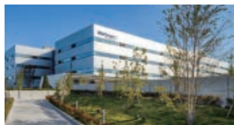
新電元工業 朝霞事業所 (埼玉県) 2021年 建物内部のアトリウムと一体化したウェルネスオフィスと環境性能を実現 2022年照明デザイン賞、2022年照明施設賞、ZEB Ready (52%省エネ)、CASBEE建築Sランク、CASBEEウェルネスオフィスSランク
