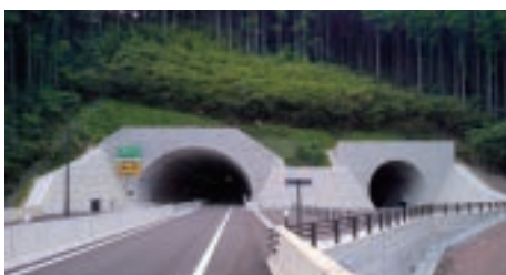
二重峠トンネル(阿蘇工区) (熊本県) 2020年 熊本地震からの早期復旧に対応するためにトンネル新設工事では国内初となるECI方式を採用し、通常の工程の約半分で掘削を完了 2020年度土木学会技術賞
