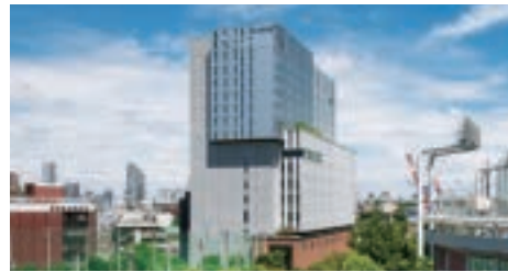
日本青年館・日本スポーツ振興センタービル (東京都) 2017年 劇場、ホテル、事務所などを備えた大規模複合建築物で、メガトラス梁のリフトアップ工法を採用
