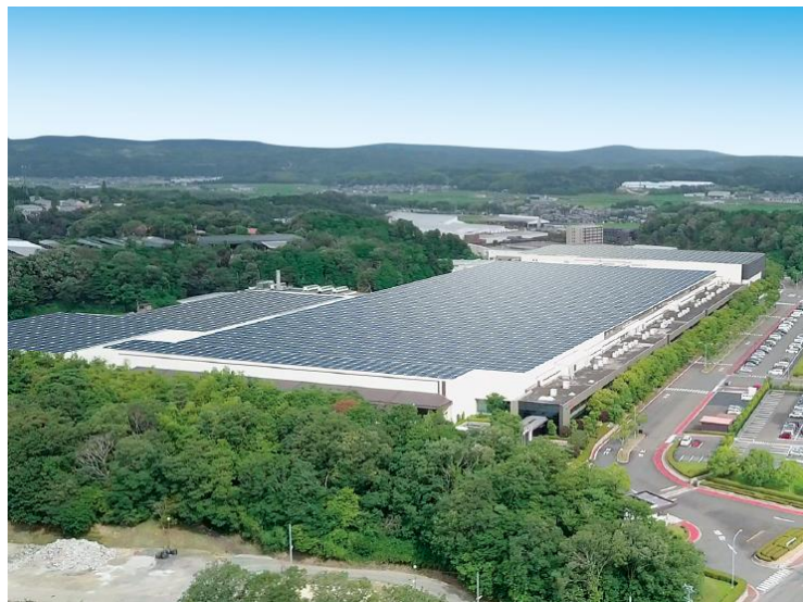
伊賀事業所 太陽光発電システム設置イメージ（提供：DMG 森精機）
