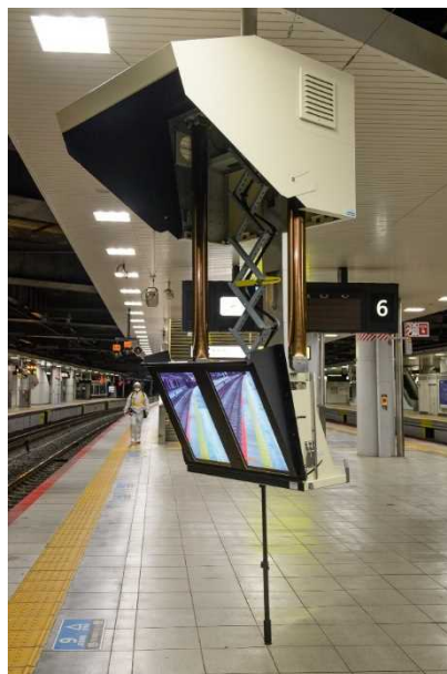
京都線新大阪駅 5 番線の昇降式ハウジング ※モニター部を引き下ろした状態。通常は上部に格納
