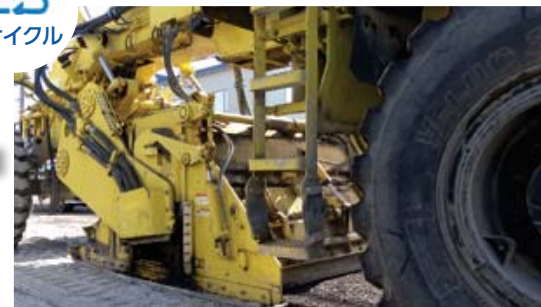
スタビセメントRC工法
