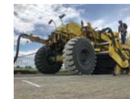
⑥ ICT技術を活用したロードスタビライザによる「スタビセメントRC工法」
