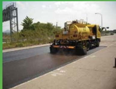
速分解型アスファルト乳剤 「スーパータックゾール」
