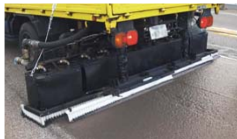
専用車両による敷き均し状況
