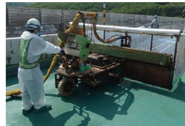
HQハイプレAU工法(バイнда散布ロボットによる施工状況)
