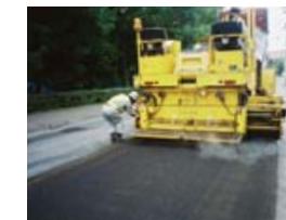
④ ひび割れの発生を遅延させる「エマルテックSAM工法」
