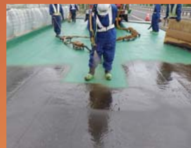
高性能型橋梁床版防水工法 「HQハイブレンAU工法」
