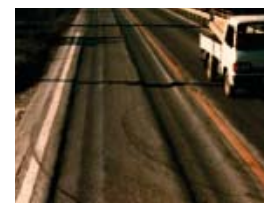
② モータリゼーションの進展により生じるわだち掘れの対策に「ポリファルトSS」
