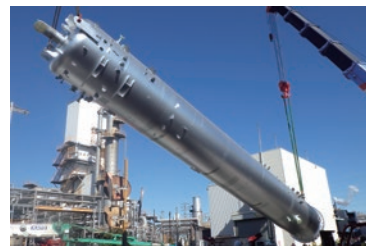
千鳥工場の吸収塔更新工事
