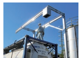
車両上からの墜落防止対策
