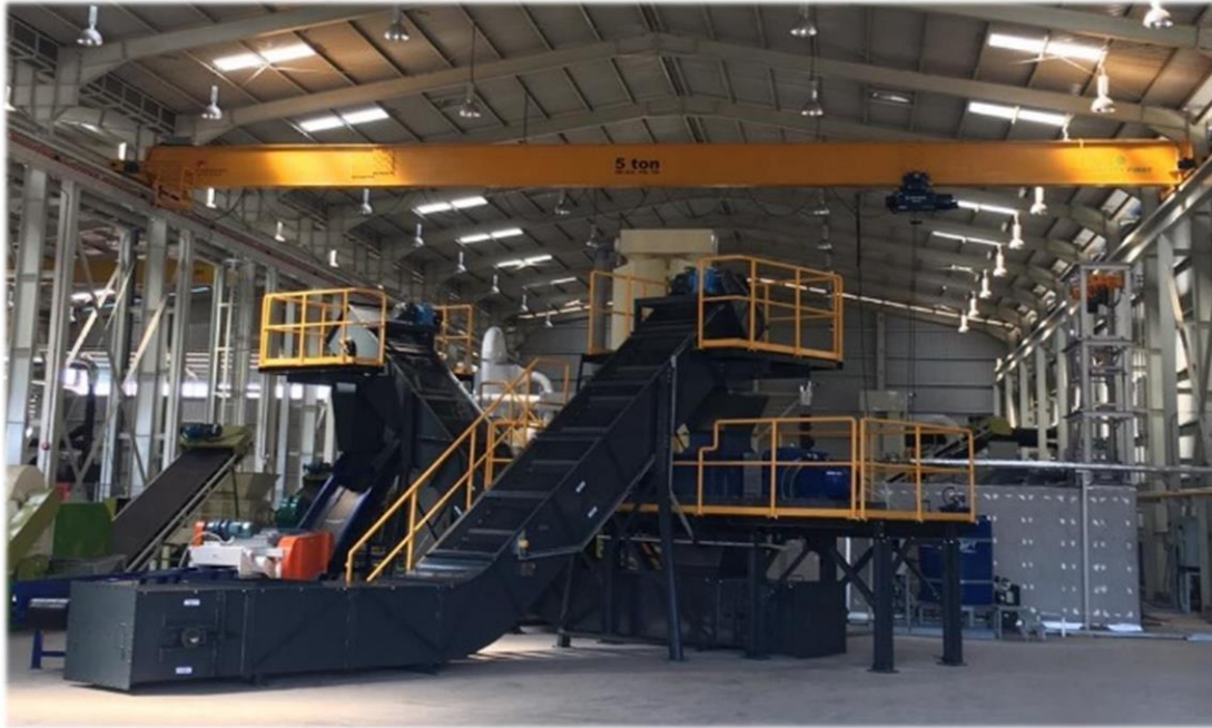
PT PTEC RESEARCH AND DEVELOPMENT パイロットプラント (バタム島リアウ諸島州 カビル工業団地)
