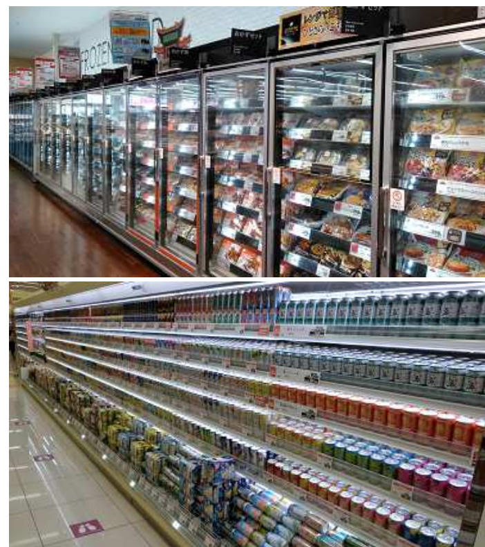
老朽化設備の一新
