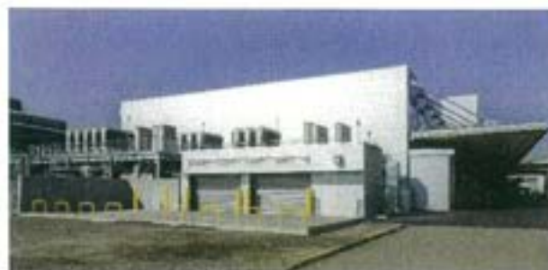
【エキシマレーザー関連建屋の増築部】
