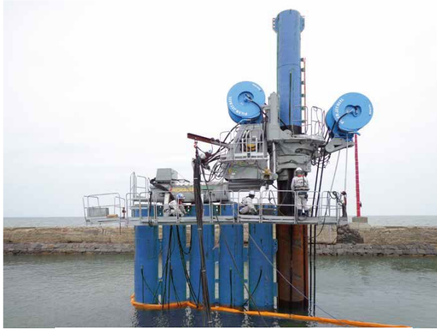
福岡県大牟田市での護岸補強工事
