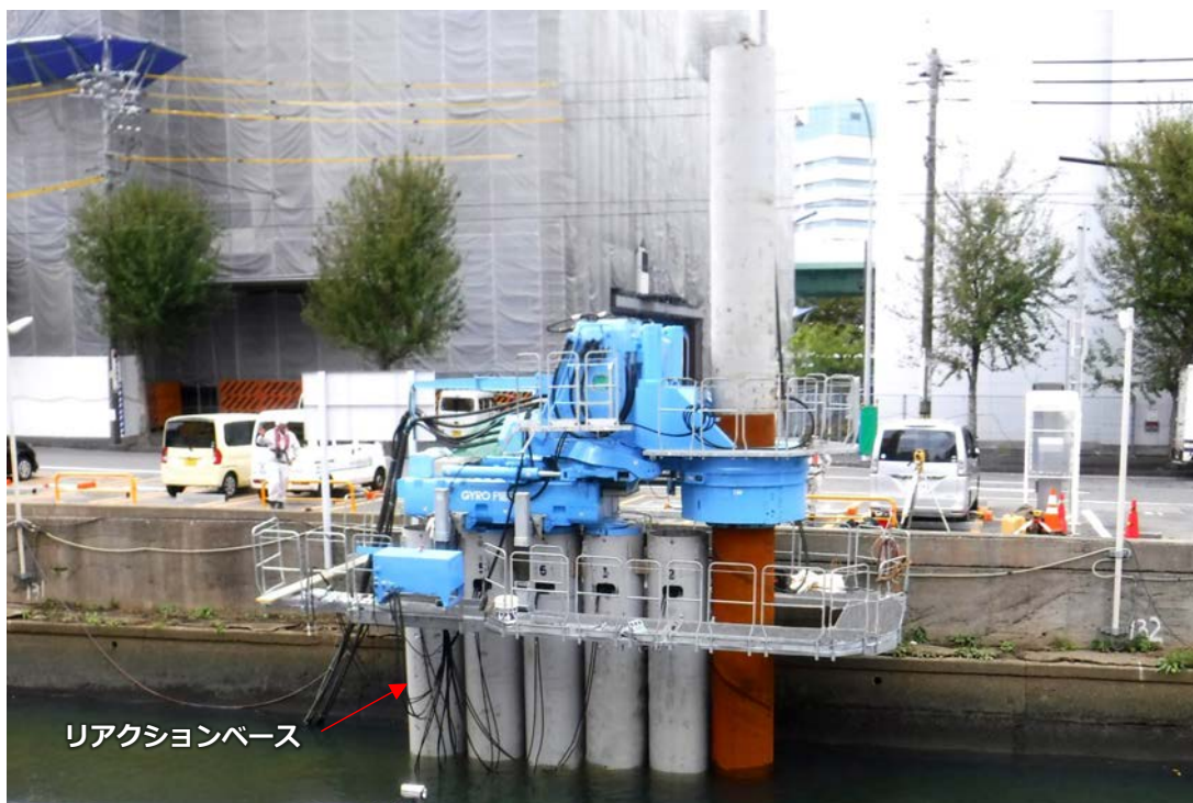
「リアクションベース」を用いた河川改修工事
