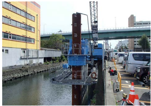
愛知県名古屋市での河川改修工事
