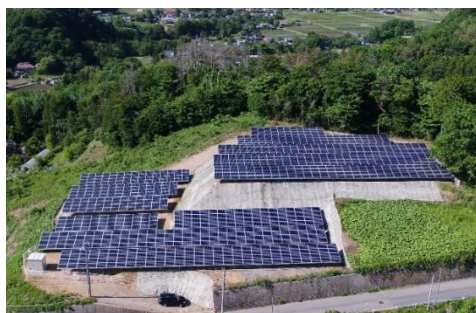
群馬県発電所
