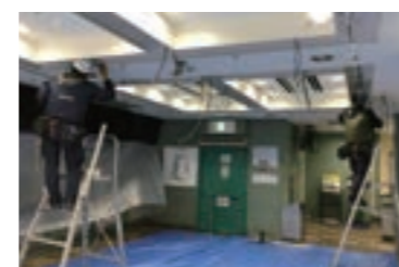
照明のLED化工事
