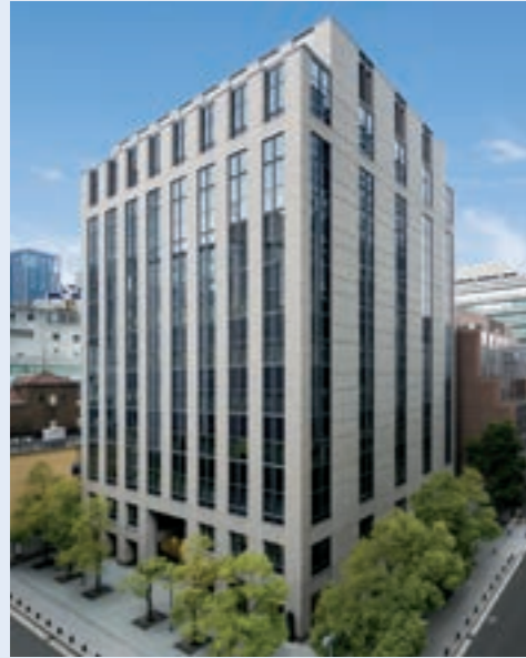
京阪神 淀屋橋ビル
