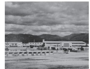
阪神競馬場 1949年竣工
