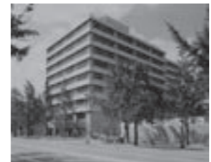
瓦町ビル 1962年竣工
