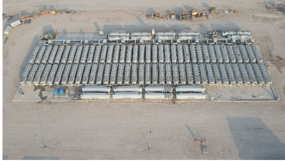
円筒槽（直径：約2m×長さ：約10m）
