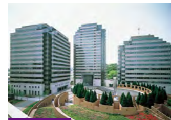
1990年～竣工 民間単独では最大級の業務系開発「横浜ビジネスパーク(YBP)」竣工
