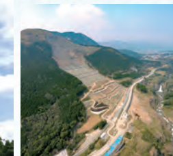
2017年 阿蘇大橋地区 斜面防災対策工事
