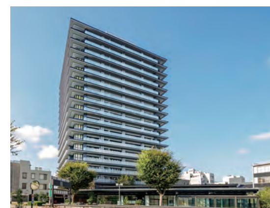
金沢駅武蔵南地区第一種市街地再開発事業施設建築物等新築工事
