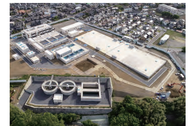
上坪浄水場更新事業施設建設工事
