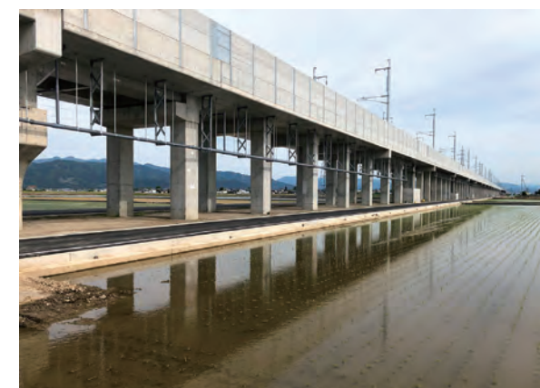
北陸新幹線坂井高架橋
