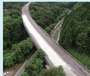
東北自動車道十和田管内高速道路リニューアル工事
