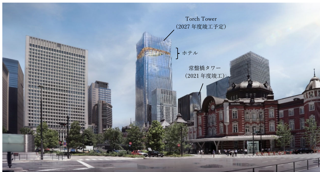
▲TOKYO TORCH 全体開業時外観イメージ／東京駅丸の内側より
