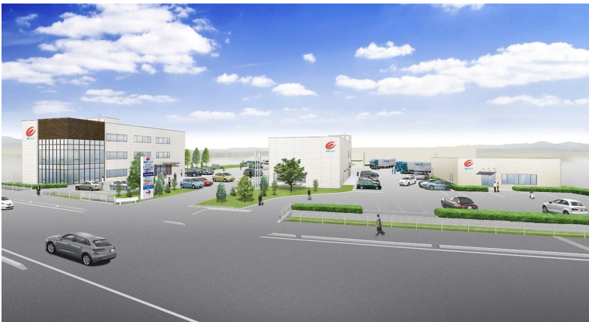
左から本社棟、本社事業部棟（配車センター）、福利厚生棟
