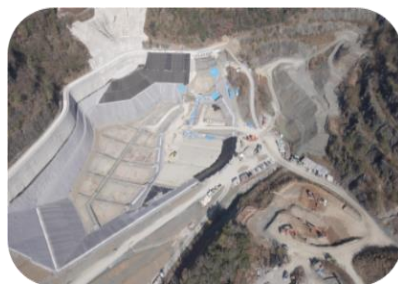
2022年2月 稼働 新規管理型最終処分場
