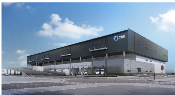
22 ロジスクエア白井 2022年12月竣工予定
