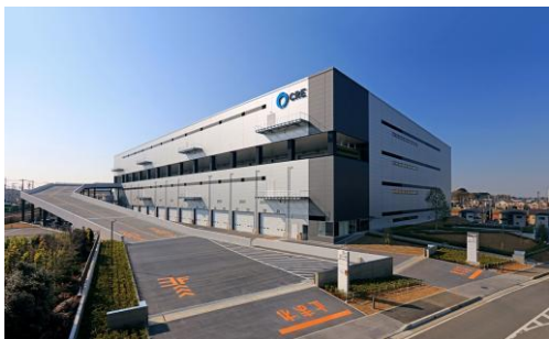
7 ロジスクエア浦和美園 2017年4月竣工
