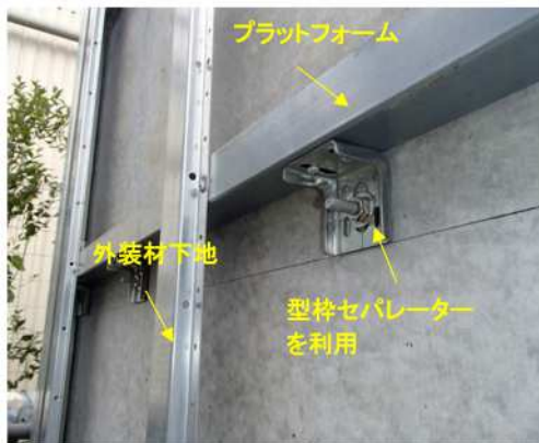
鋼製下地(プラットフォーム)詳細
