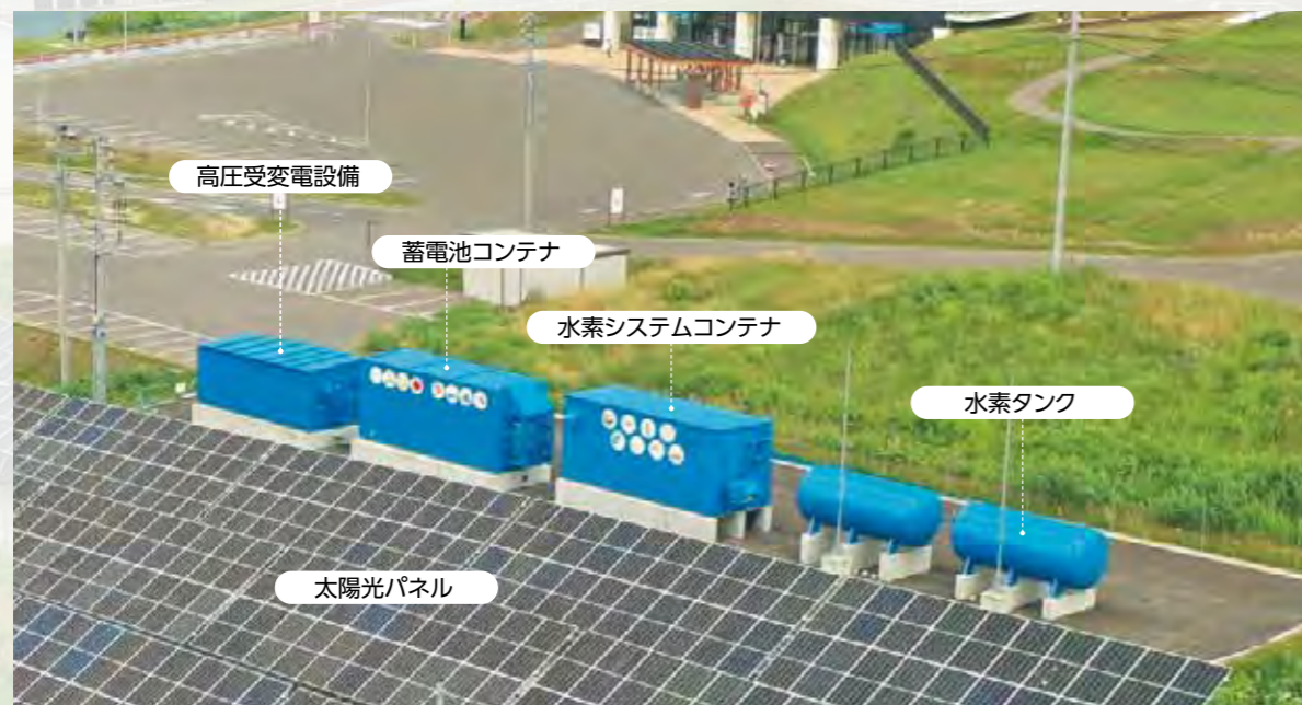
石狩市厚田マイクログリッドシステム外観 (写真提供:石狩市)
