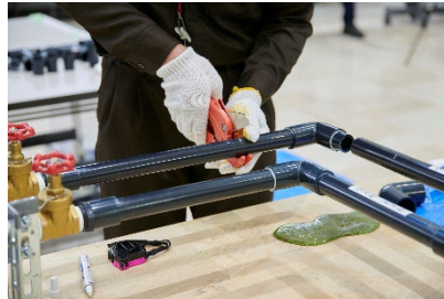
● 給水ポンプ配管復旧の一次対応
