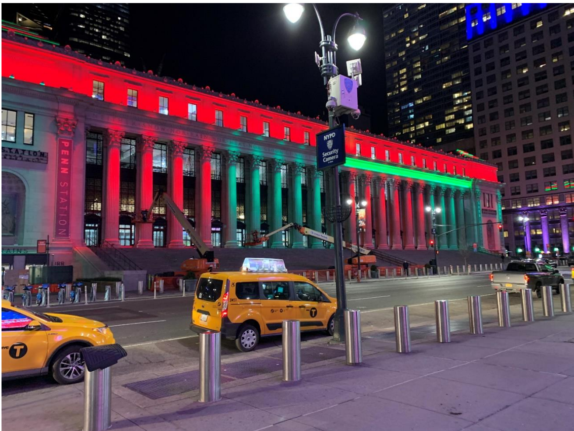
ペンシルバニア駅の拡張工事により駅舎としてリニューアルされたモイニハントレインホール
