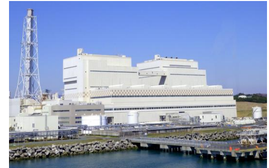
原町火力発電所
