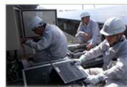
発電所の検査サービス
