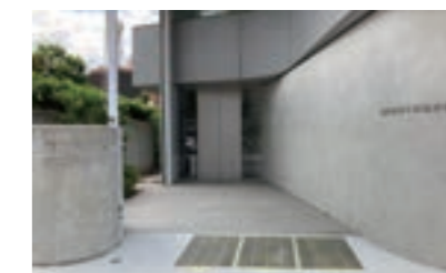
本社ビル エントランスに敷設
