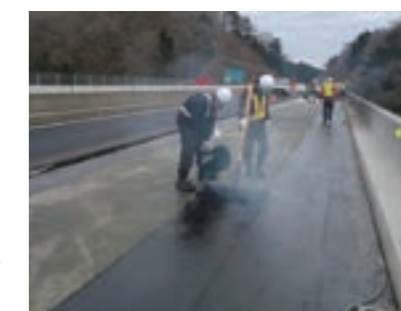
CAMシール NEOプラス施工状況
