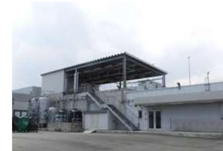
大型航空機洗機施設
