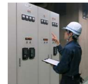
保守点検作業
