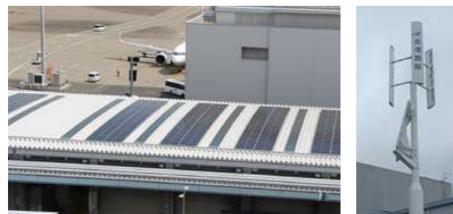
自家消費型の羽田空港国内貨物ターミナル太陽光発電設備(左)とハイブリッド・自立型電灯(右)
