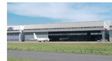
西側格納庫 (羽田空港)
