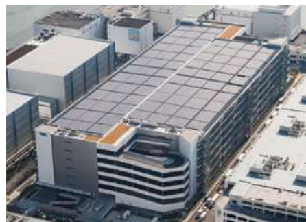
TRC物流ビルB棟屋根ソーラー発電所
