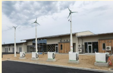
情報発信拠点「道の駅なみえ」 再生可能エネルギーと連携するグリーンEVシステム
