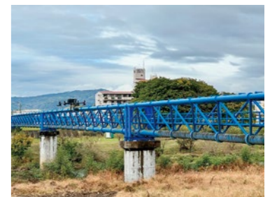
ドローンによる水管橋の点検
