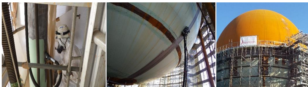
左：塗膜剥離（従来法） 中：塗膜剥離（三谷産業によるマシン式） 右：ベステラによる上半球の塗膜剥離が完了
