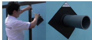
気密部材の施工事例
